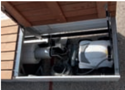
Zona práctica de almacenamiento
